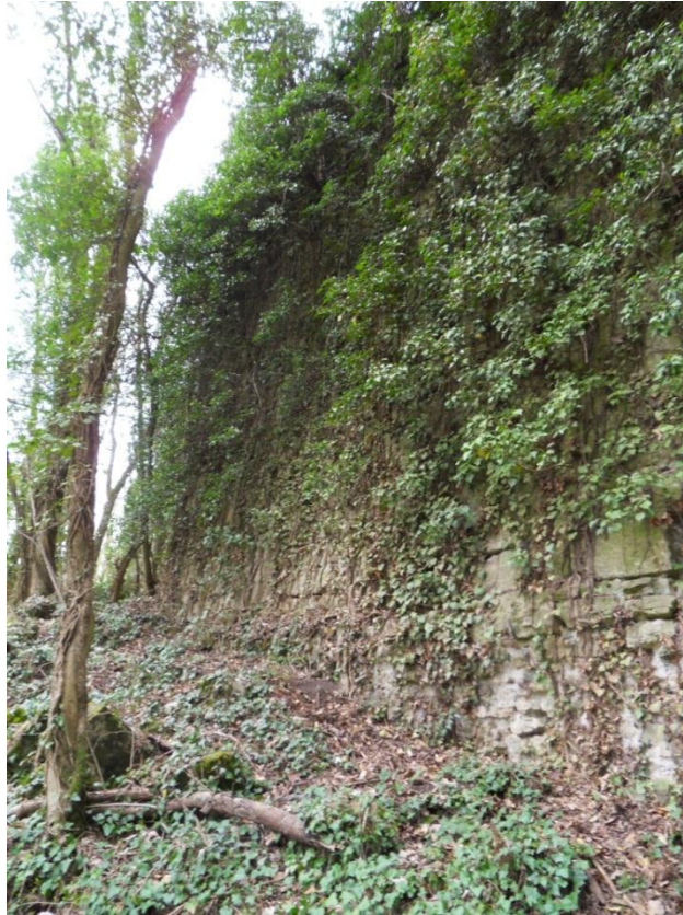
Photo 1 : Vue d'ensemble sur la zone 10.
