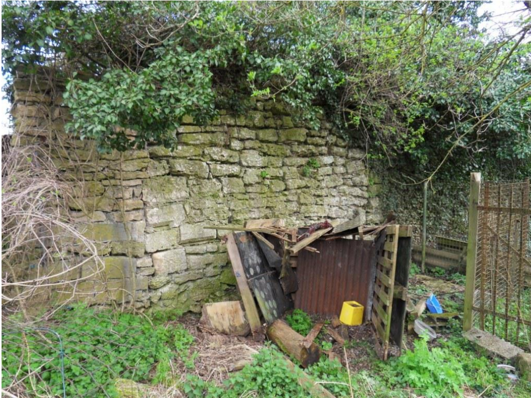
Photo 3 : Partie nord du mur.
