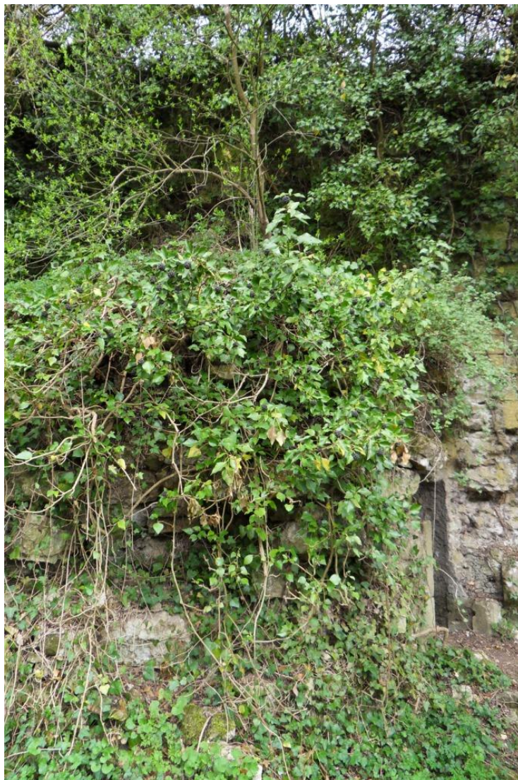
Photo 3 : Partie sud de la tour.
