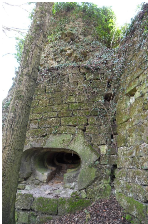
Photo 3 : Jointure entre la tour et la zone 4 (vue sur l'ouverture).
