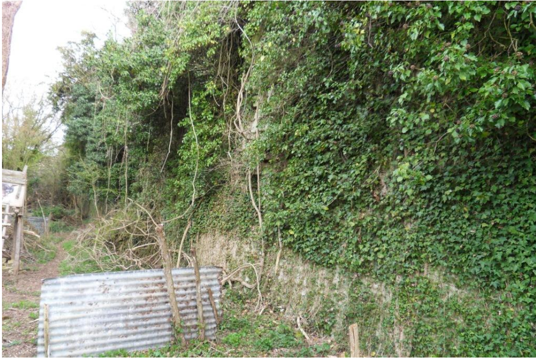
Photo 1 : Vue d'ensemble sur le mur.
