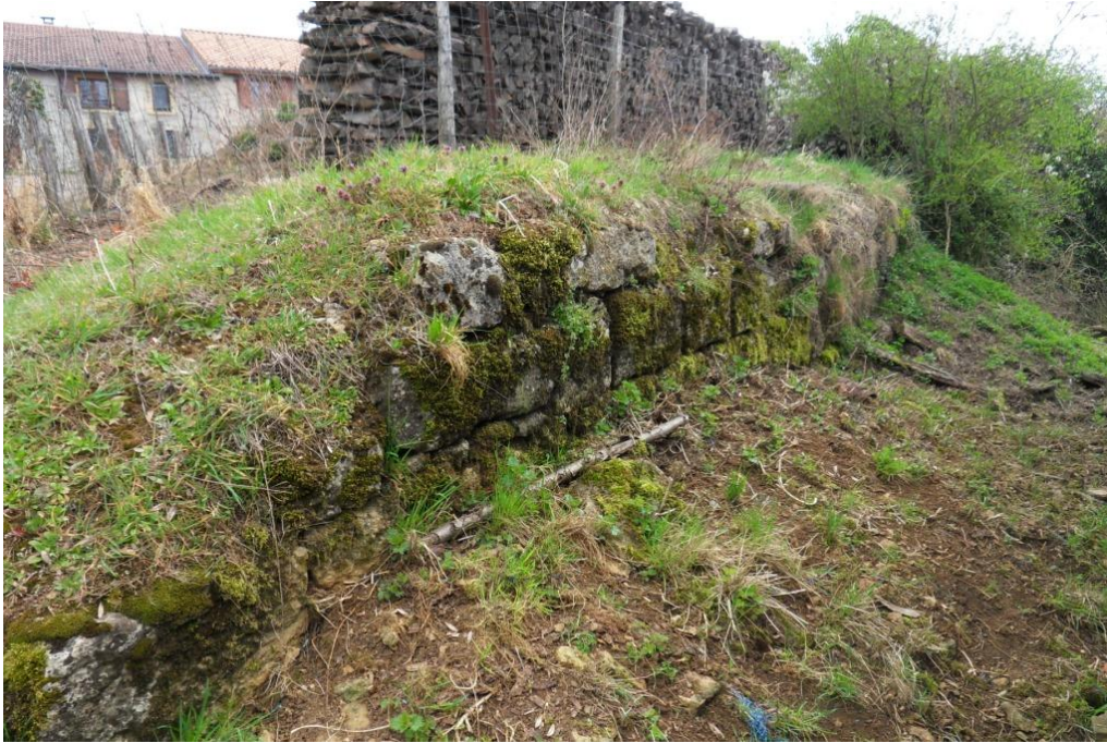
Photo 1 : Vue générale du mur.
