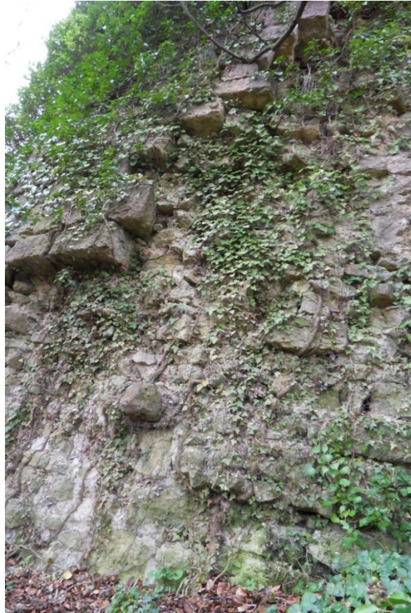
Photo 1 : Gros plan sur le démantèlement de la tour.
