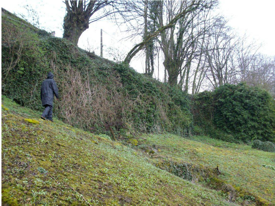
Photo 1 : Vue d'ensemble sur le mur.
