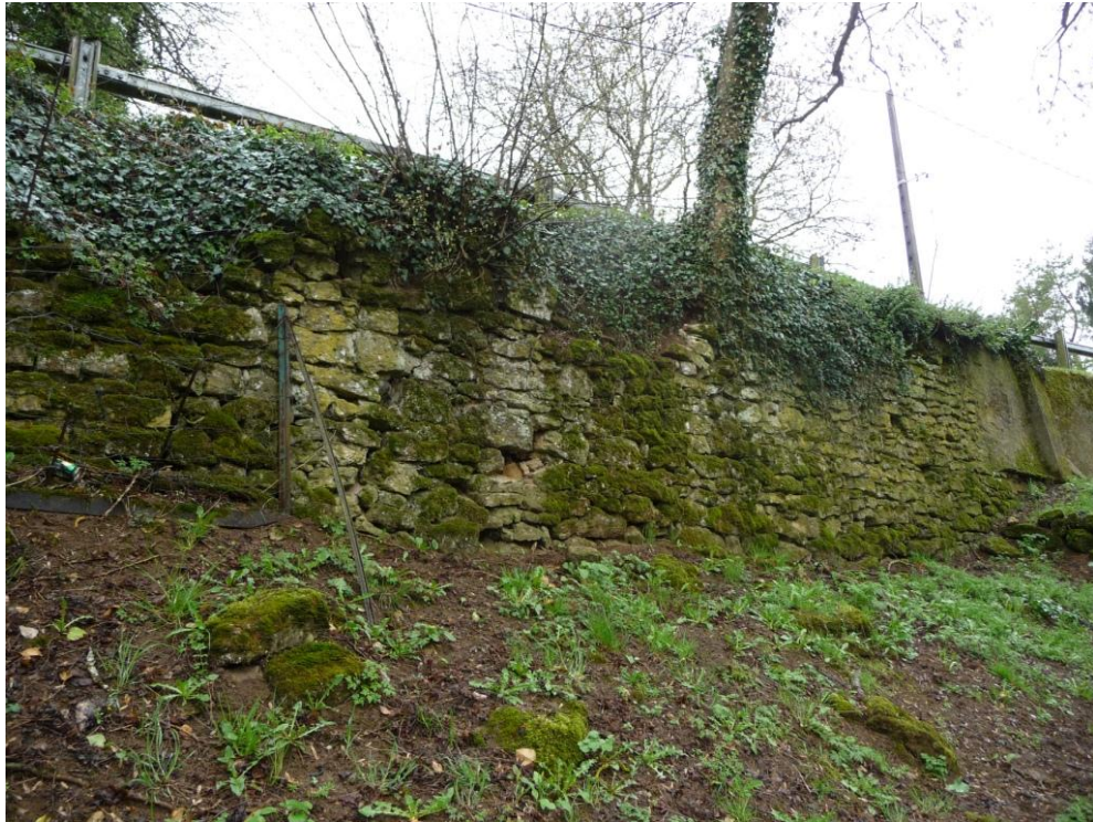
Photo 3 : Partie ouest du mur.
