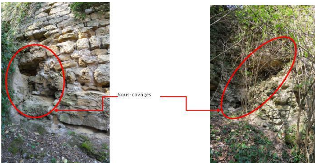
Photo 2 : Photo de gauche : gros plan sur un sous-cavage (Est de la tour). Photo de droite : angle SE de la tour à la limite de la zone 4.
