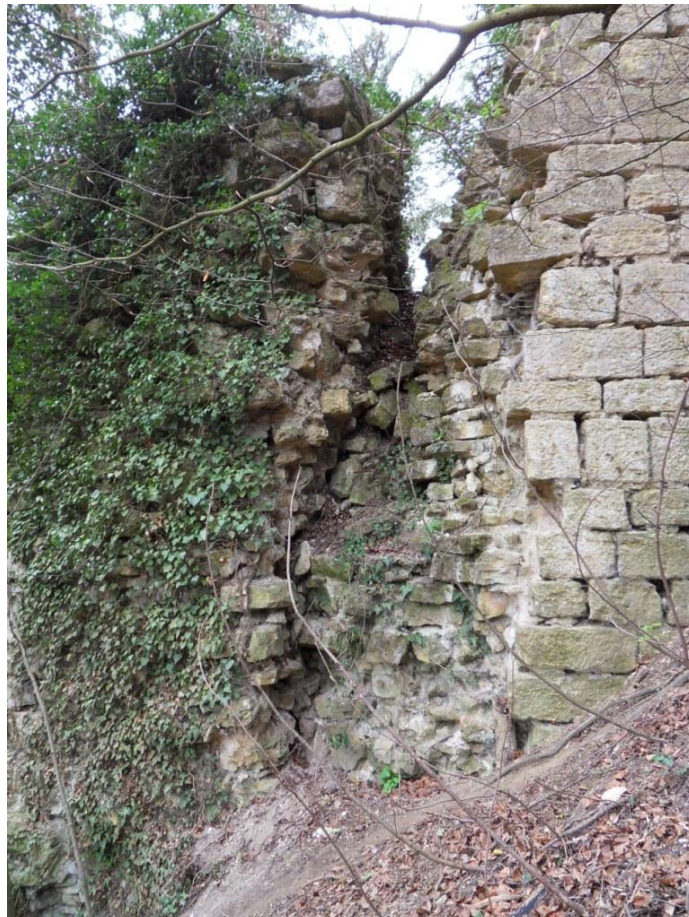
Photo 2 : Gros plan sur le démantèlement de la jonction entre le mur et la tour.
