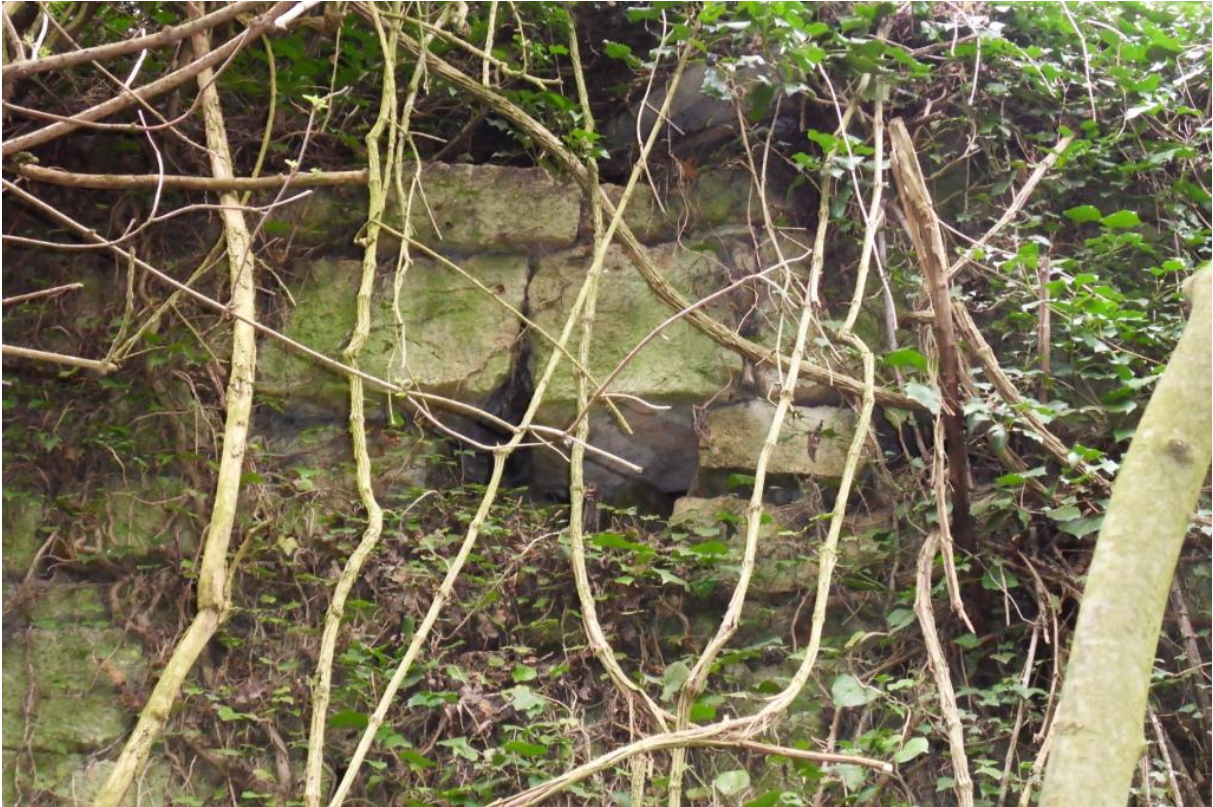
Photo 5 : Blocs déjointoyés.
