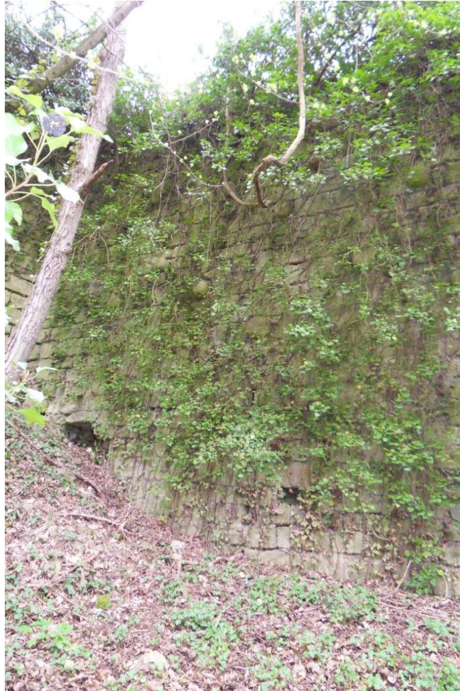
Photo 1 : Partie ouest de la zone 11.
