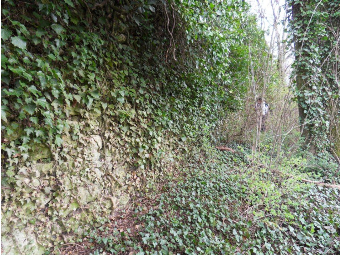
Photo 1 : Vue sur le mur en direction du sud.
