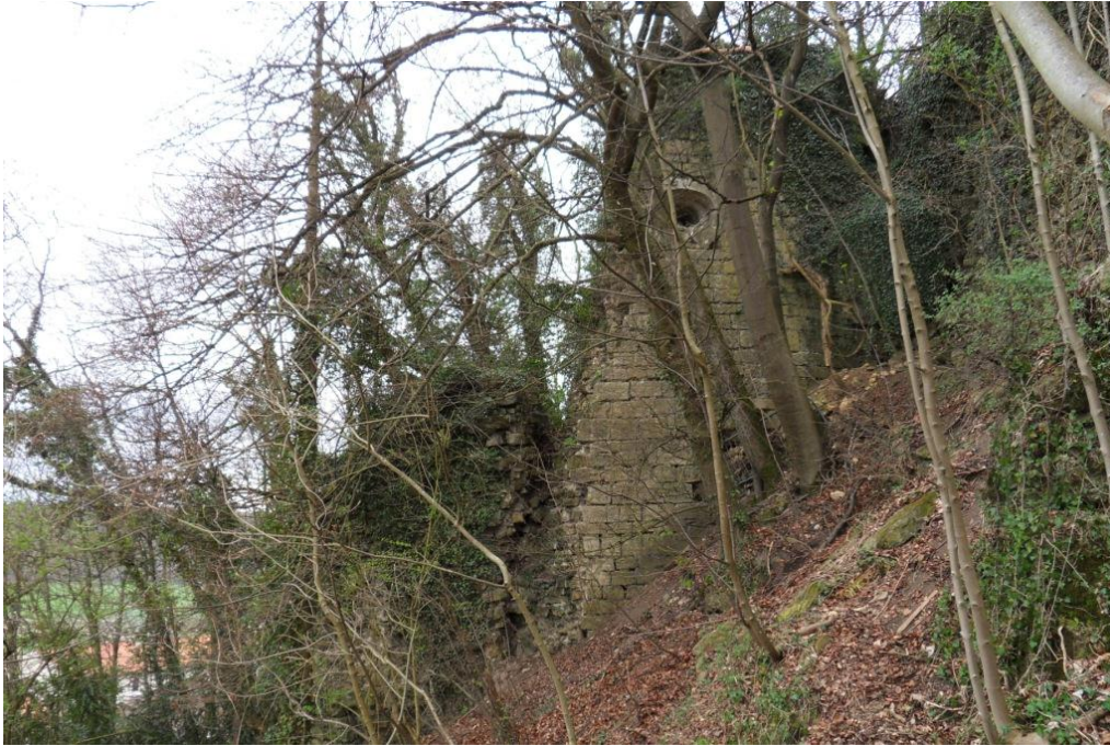
Photo 1 : Vue d'ensemble de la zone 8 ( face nord de la Tour des Moines).
