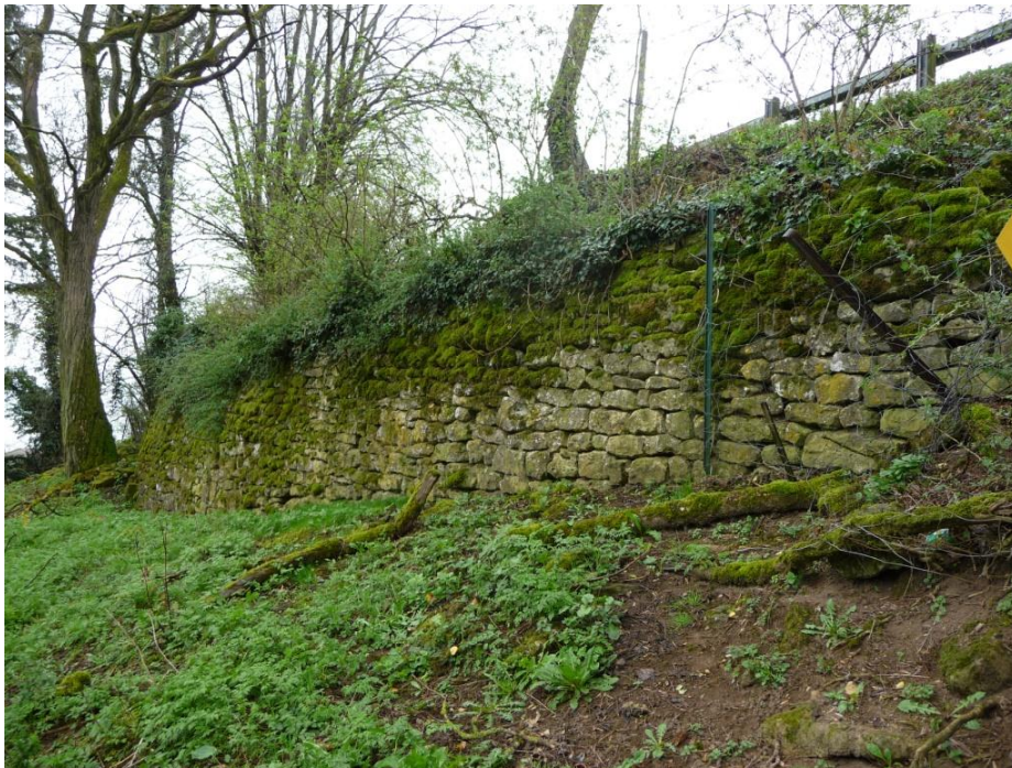
Photo 2 : Partie centrale du mur.
