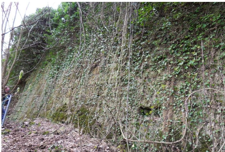
Photo 1 : Vue sur la partie végétalisée du mur.
