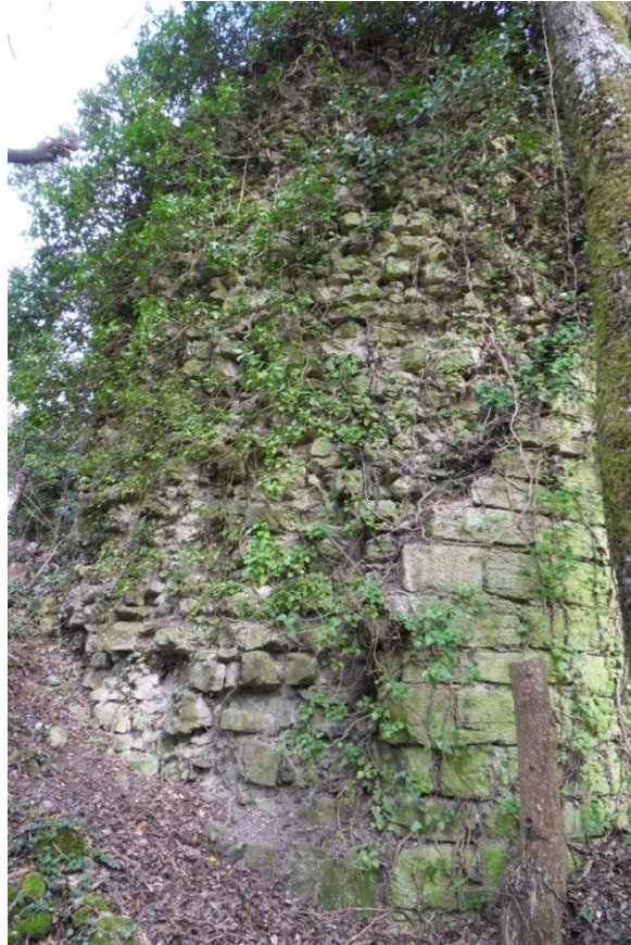
Photo 1 : Vue d'ensemble sur la partie démantelée de la tour.
