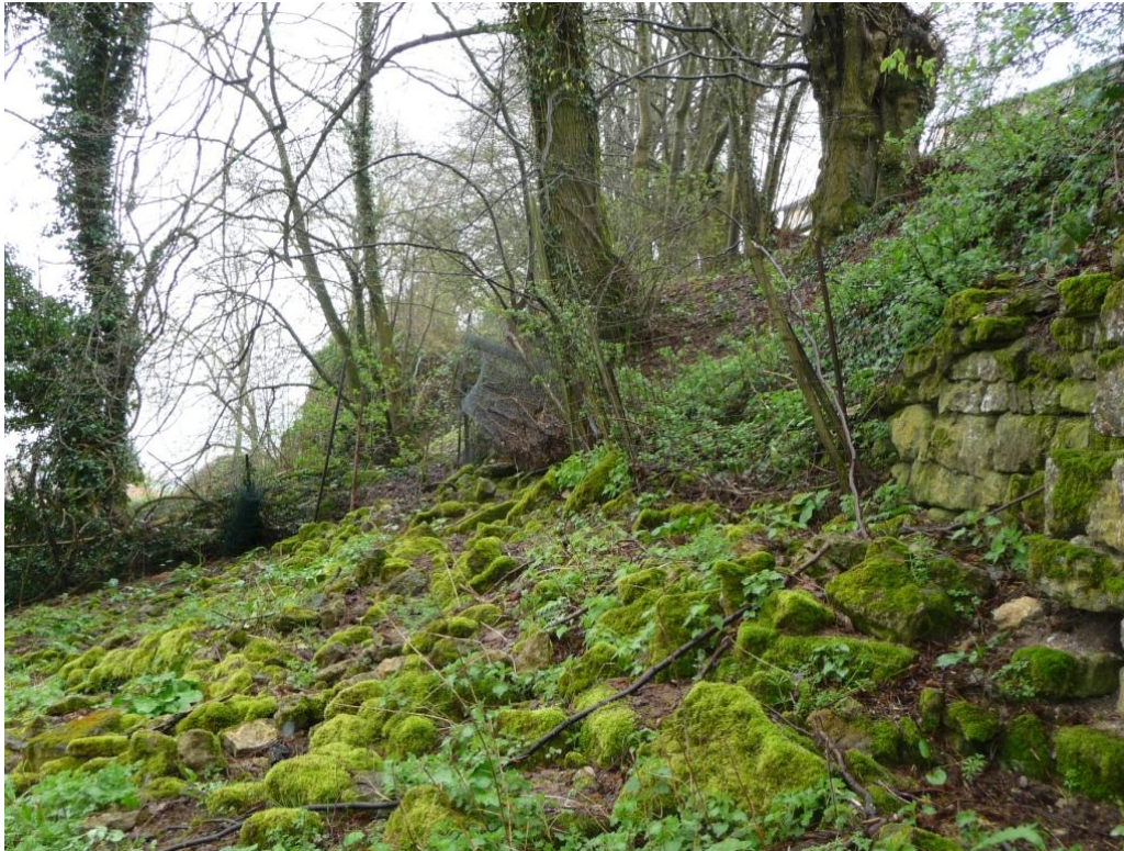
Photo 1 : Partie est du mur.
