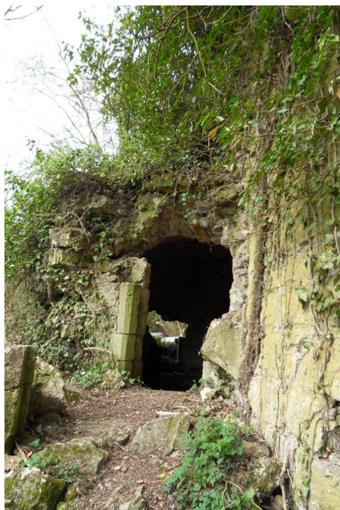
Photo 2 : Partie Est de la tour et vue sur l'arche.
