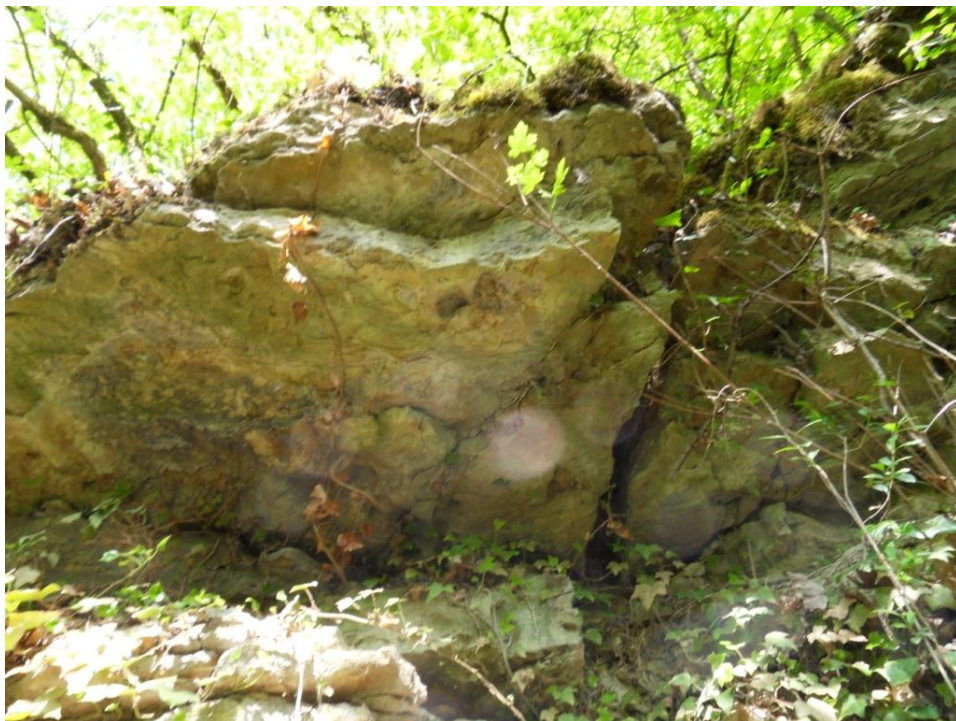
Photo 15 : Fracturation et blocs instables.
