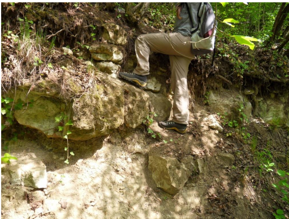
Photo 5 : Sous les bancs calcaires, les horizons marneux sont à l'origine des sous-cavages.
