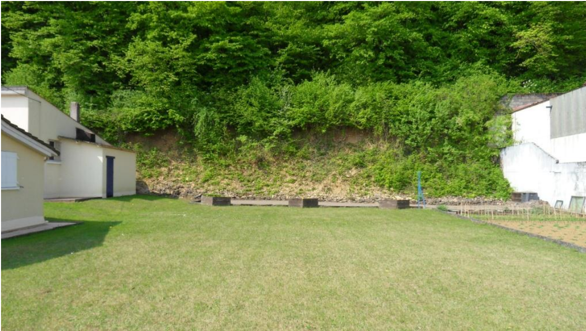
Photo 25 : Vue du talutage anthropique dans les éboulis (parcelle 32).
