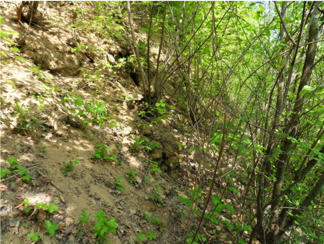
Photo 22 : Vue de l'affleurement (parcelles 23-24) La roche en place est presque entièrement recouverte par le talus d'éboulis.
