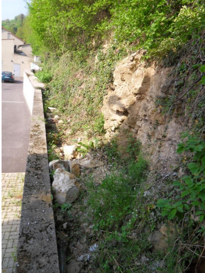
Photo 3 : Vue de la fosse de réception.
