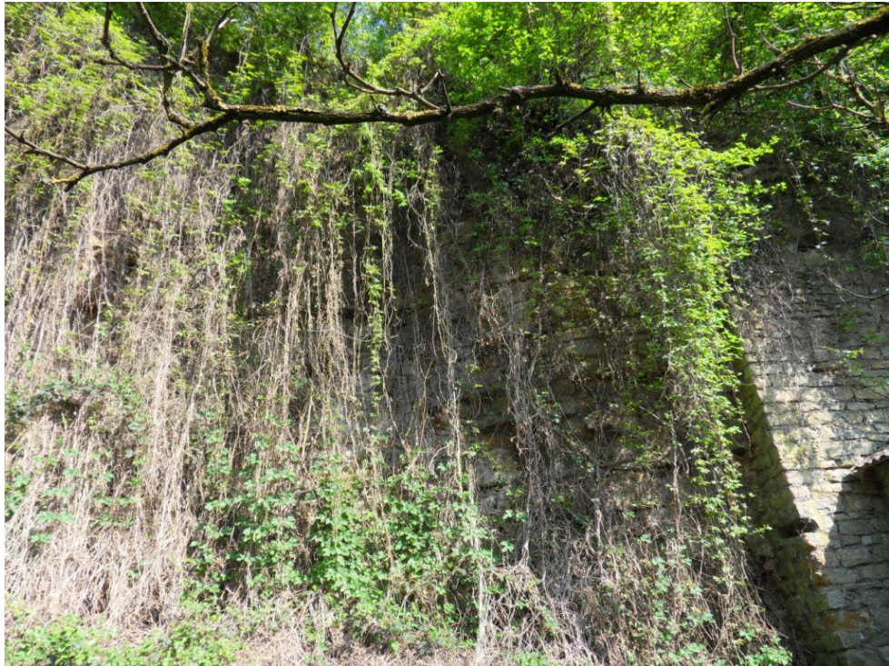
Photo 1 : Corniche de 11 m de haut.
