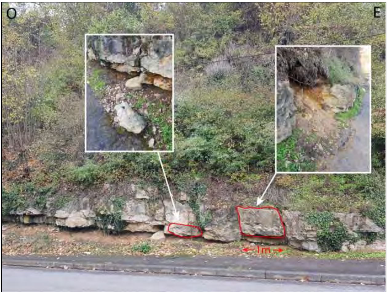
Illustration 11 - Photo de l'affleurement A03 avant que l'événement ait eu lieu avec une comparaison des chutes de blocs relevées en février 2021. Les blocs sont d'environ 75 L (gauche) et d'environ 150 L (droite).
